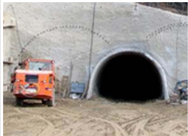
Západná pilierová štôlna tunela Bôrik na diaľničnom úseku Mengusovce - Jánovce, ktorú môžu vidieť aj vodiči prechádzajúci po ceste I/18 od Štrby do Svitú. (SITA/Rastislav Ovšonka)
