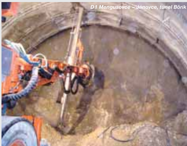
D1 Mengusovce - Jánovce, tunel Bôrik
