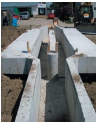
Objekt hrubého predčistenia pripravovaný na montáž technológie.
