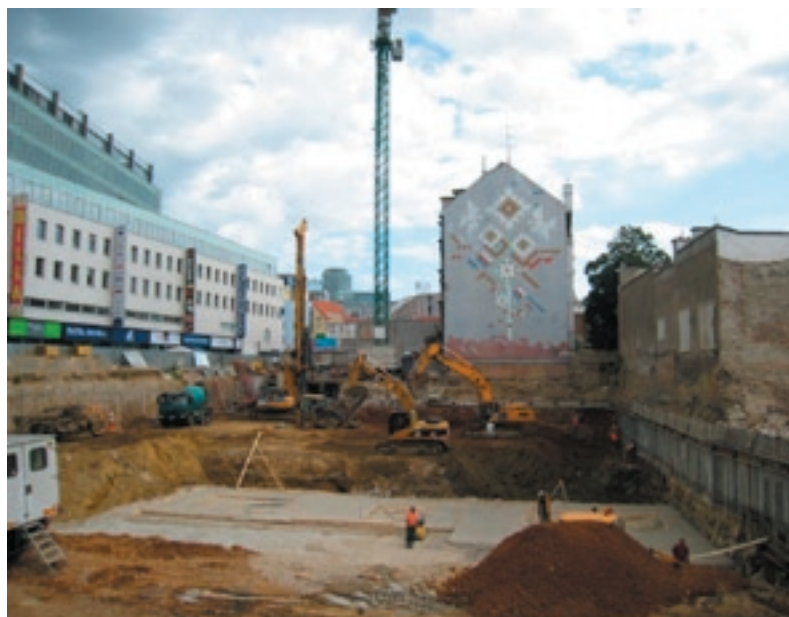
Pohľad na výkop stavebnej jamy
