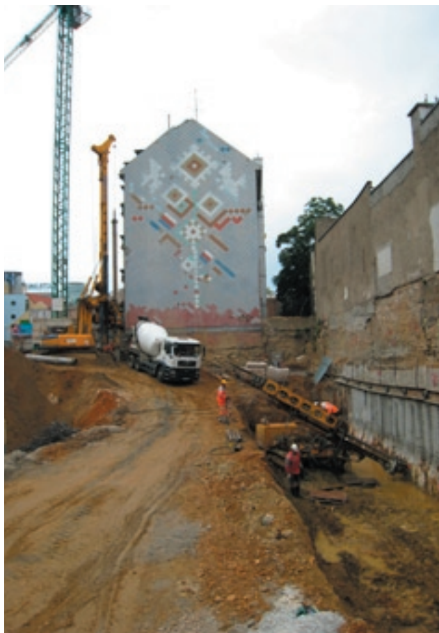
Realizácia dočasných lanových kotiev
