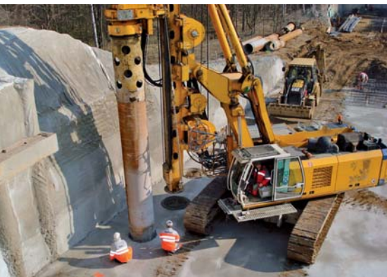
Žilina Europalace – realizácia základových veľkopriemerových pilót
