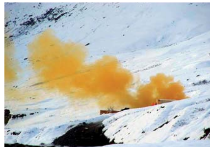
Podzemná elektrárňa Sisimiut v Grónsku – pohľad na servisný tunel po odpale
