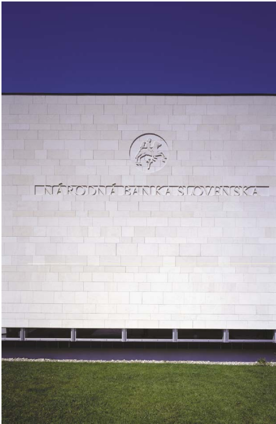
Celkový dojem mohutnosti nízkej hmoty pomáhajú zjemniť prvky kamenného obkladu a kompozícia otvorov.
